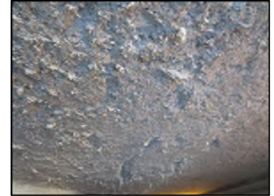
Photo N° 663 ECH-N°1 FLOCAGE -- LOCAL POUBELLE Plafonds blanc cotonneux
